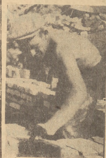
Pracujący murarz PPB Nr 10 tow. Jerzy Rychert w czasie ustanawiania nowego rekordu Polski w budownictwie
