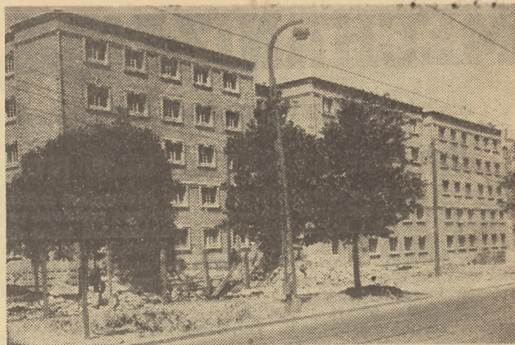
Żołęta i kierownictwo oddziału IV PPB Muranów zobowiązały się dla uczczenia święta 22 lipca ukończyć budowę kilku bloków. Na zdjęciu: blok nr 36 w osiedlu Muranów w Warszawie zbudowany systemem potokowym (Foto — AR)
