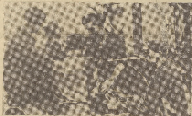
Brygada przy montażu wind
