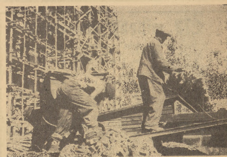
Prace przy odbudowie gdańskiego Dworu Artusa posuwają się w szybkim tempie naprzód. W niedługim czasie budowla ta stanowića cenny zabytek przybierze swój historyczny wygląd. Na zdjęciu: robotnicy PPE na tle rusztowań podczas usuwania gruzów z piwnicy.
