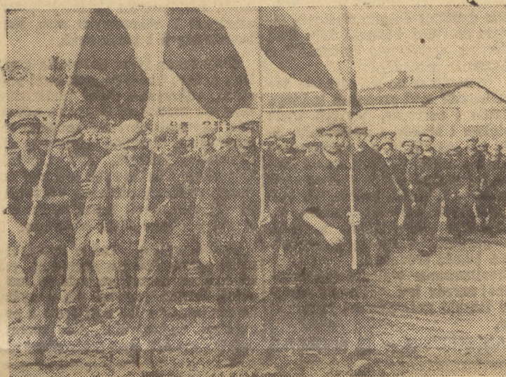
Przy budowie Nowej Huty pod Krakowem, pracują tysiące ZMP-owców i junaków SP. Dzisiejsi budowniczy nowego miasta, będą w przy- szłości jego mieszkańcami.
