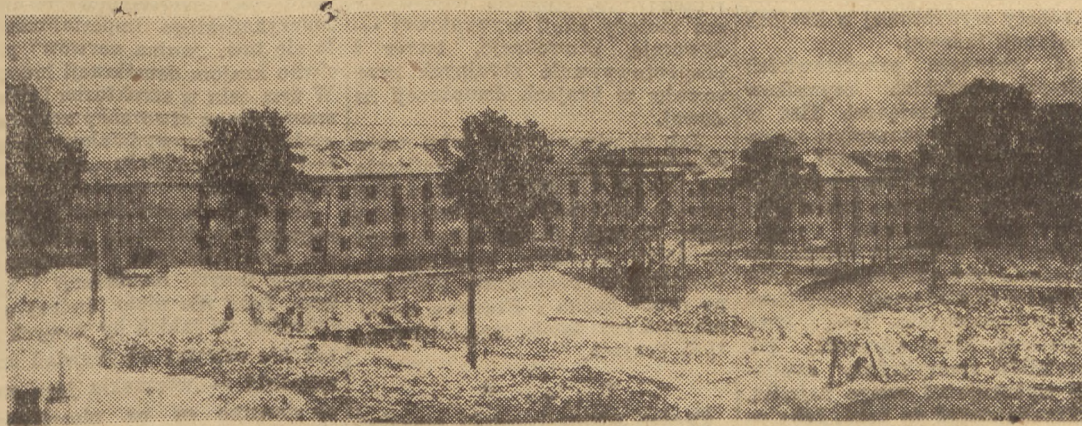
Budowa domów mieszkalnych w Nowej Hucie.
