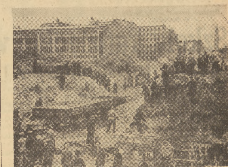
Dnia 1 września br. przystąpiono do pracy na terenach, przeznaczonych pod trasę N-S. Na zdjęciu: pierwsze ochotnicze brygady, złożone z pracowników stołecznych zakładów pracy. (Foto—AR)
