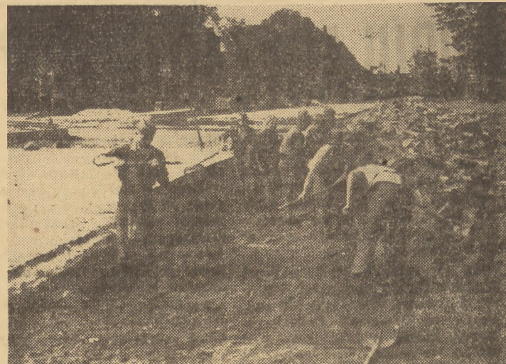
Z początkiem września na terenie całego kraju rozpoczął pracę III turnus brygad „SP”. Janacy 18 brygady „SP”, obozującej w Orlowie, przystąpili do dalszych robót przy budowie drogi Gdańsk — Gdynia. Na zdjęciu: junacy 2 plutonu IV kompanii podczas pracy.
