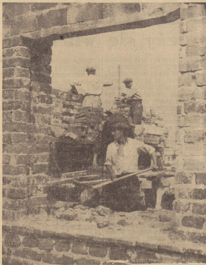
Na Kole, w Warszawie, prowadzona jest budowa domków jednorodzinnych. Budowa pierwszej serii domków zostanie zakończona jeszcze w roku bież. Na zdjęciu: fragment budowy.
