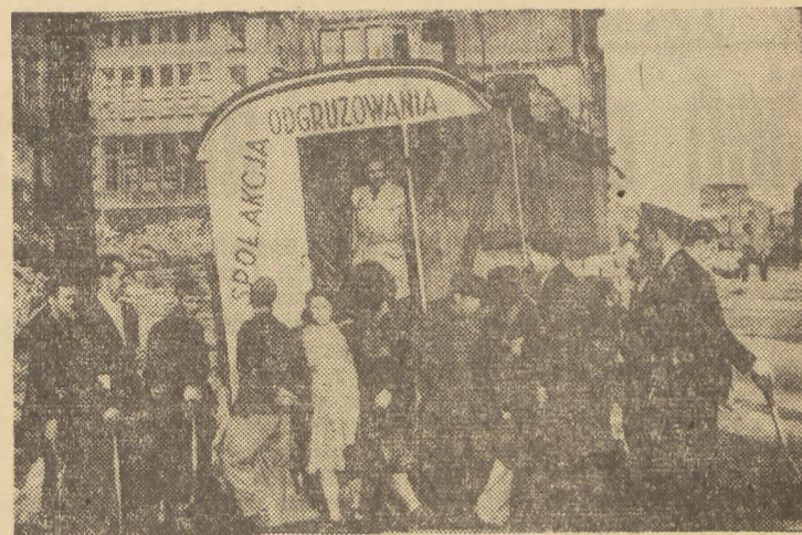
W społecznej akcji odgruzowywania Gdańska biorą udział robotnicy różnych zakładów pracy. Na zdjęciu: załoga gdańskiej fabryki łożarskiej przed rozpoczęciem pracy.
