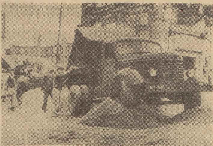
Tempo odbudowy Starego Gdańska wzrasta dzięki mechanizacji pracy. Na zdjęciu: samochody-wyrotki produkcji radzieckiej przy pracy
