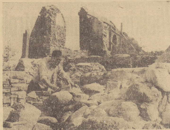
Pracownik pracy, murarz Błaszczak Józef, pracuje przy odbudowie starej wieży marszałkowskiej Starego Miasta (Foto — AR)
