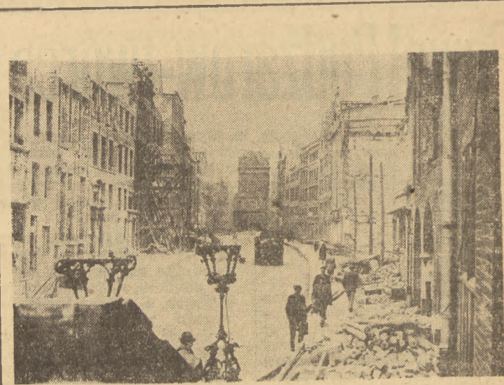
Dzięki mechanizacji pracy posuwa się szybko naprzód odbudowa Gdańska. Na zdjęciu: ul. Długa.
