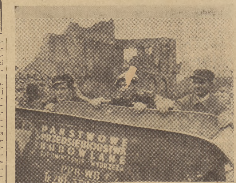
Robotnicy brygady rozbiórkowej PPB „Zjednoczenie Wybrzeża”. Paweł Ciecholewski, Grzegorz Glinka i Władysław Sprawka, którzy w dniu 26 bm. przy robotach rozbiórkowych na Starym Mieście w Gdańsku ustalili nowy rekord polski w pracach rozbiórkowych, wykonując 2.600% normy.
