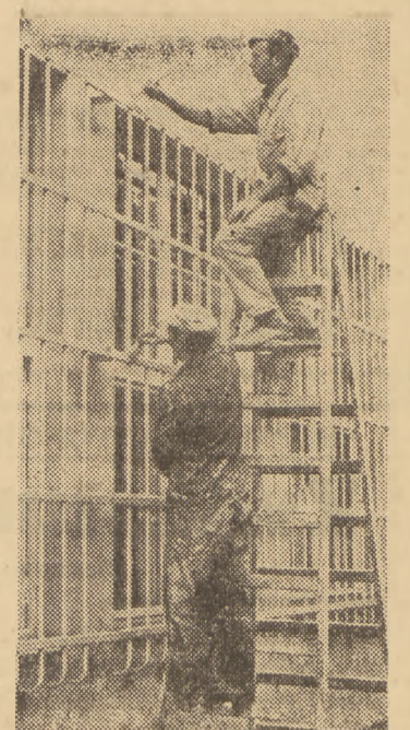
Malarze Jaworski i Meza z PPR Nr 1 podczas prac przy lakierowaniu okien.
