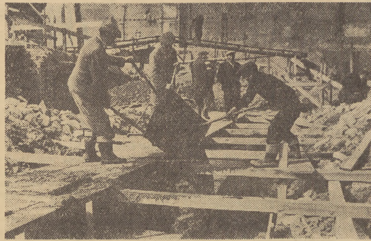
Rosnie Marszałkowska Dzielnica Mieszkaniowa. Na bloku 3a przystąpiono do betonowania ław fundamentowych. Na zdjęciu: betoniarze z grupy Zdoborczyka, wyrabiającej średnio 270% normy (Foto — AR)
