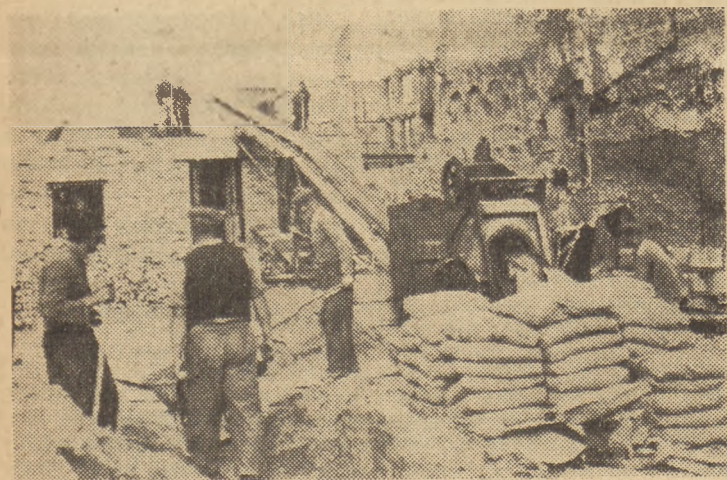
Mechanizacja pracy umożliwia robotnikom budowlanym znaczne przekroczenie norm.
