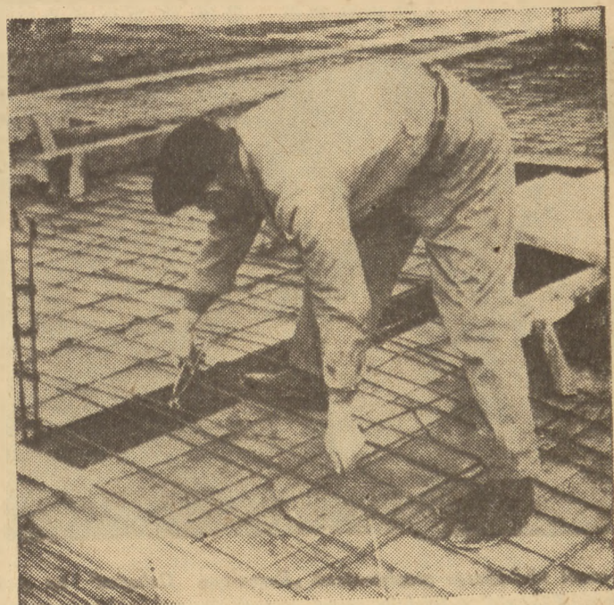
W budownictwie coraz częściej stosuje się stropy żelbetonowe. Dzięki zastosowaniu ulepszeń i pomysłów racjonalizatorskich przy zakładaniu zbrojeń uzyskuje się duże oszczędności w materiale. Na zdjęciu: robotnik PPB sprawdza wiązania zbrojenia przed zalaniem spoiwem betonowym na jednej z budowli przemysłowych w Gdyni. (Foto — Z. K.)
