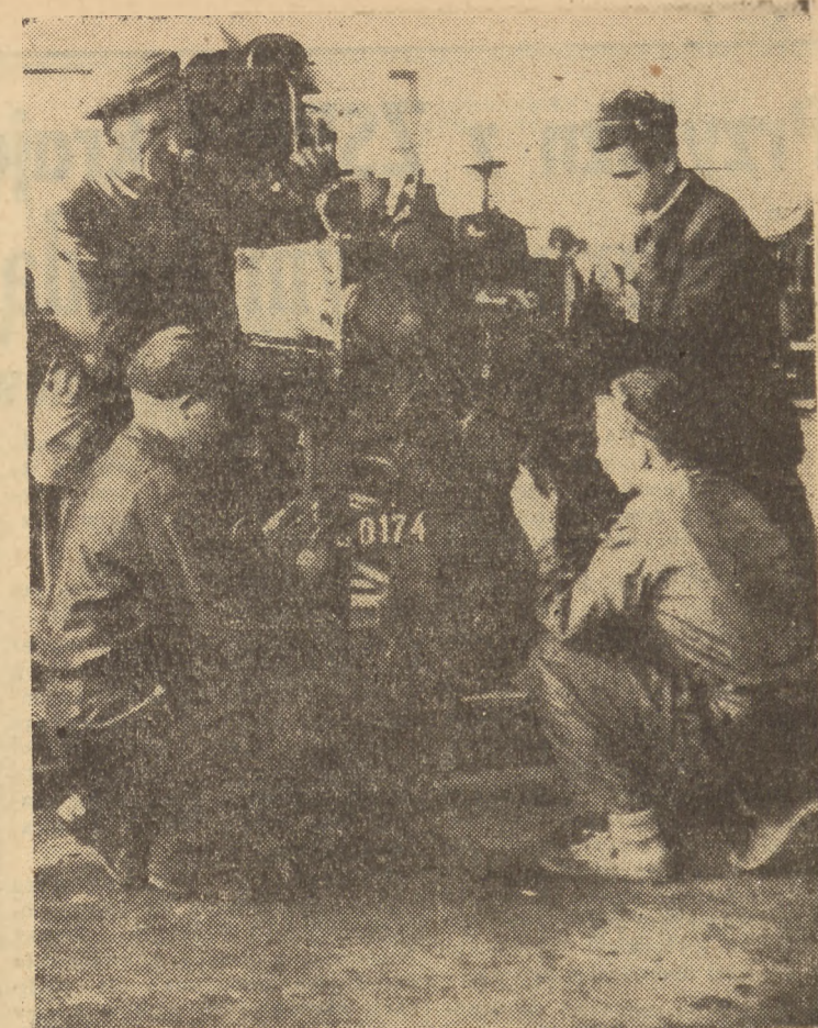
Brygadziści tow. Mielnicki z Zakładów Opakowań Blaszanych postanowił wraz ze swoją brygadą młodzieżową dla uczczenia 33 rocznicy Rewolucji Październikowej oraz Światowego Kongresu Pokoju zakończyć przedterminowo prace przy montażu nowej hali. Na zdjęciu: brygada tow. Mielnickiego w składzie tow. tow.: Makowicz, Kowalski. Blok przy pracy.
