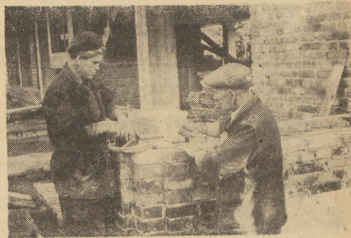
Murarze, pracujący przy budowie PDT we Wrzeszczu kończą już swe prace. Teraz kolej na cieśli, elektryków i innych specjalistów od instalacji wewnętrznych. Na zdjęciu: murarze ob. ob. Kucerański i Schulz przy pracy.
