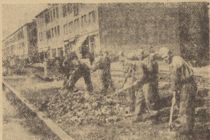
Przy nowej autostradzie we Wrzeszczu powstaną wkrótce zieleńce i szerokie chodniki. Na zdjęciu: junacy 18 brygady SP podczas równania terenów pod nowe chodniki
