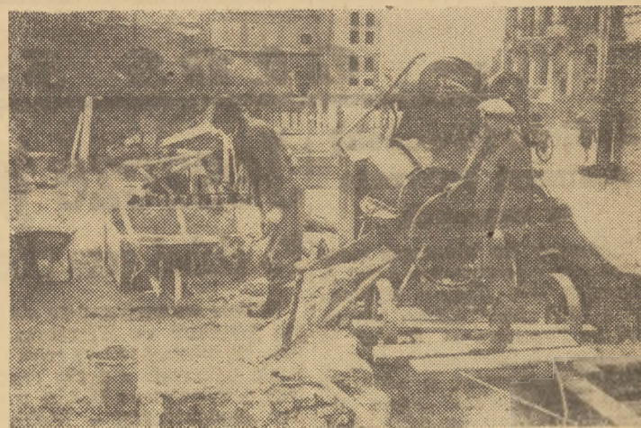
Coraz więcej betoniarek pracuje przy odbudowie Gdańska. Na zdjęciu: robotnicy PPB Nr 7 Antoni Rudek oraz Kazimierz Michorczyk podczas pracy przy betoniarce zainstalowanej przy ul. Długiej w Gdańsku
