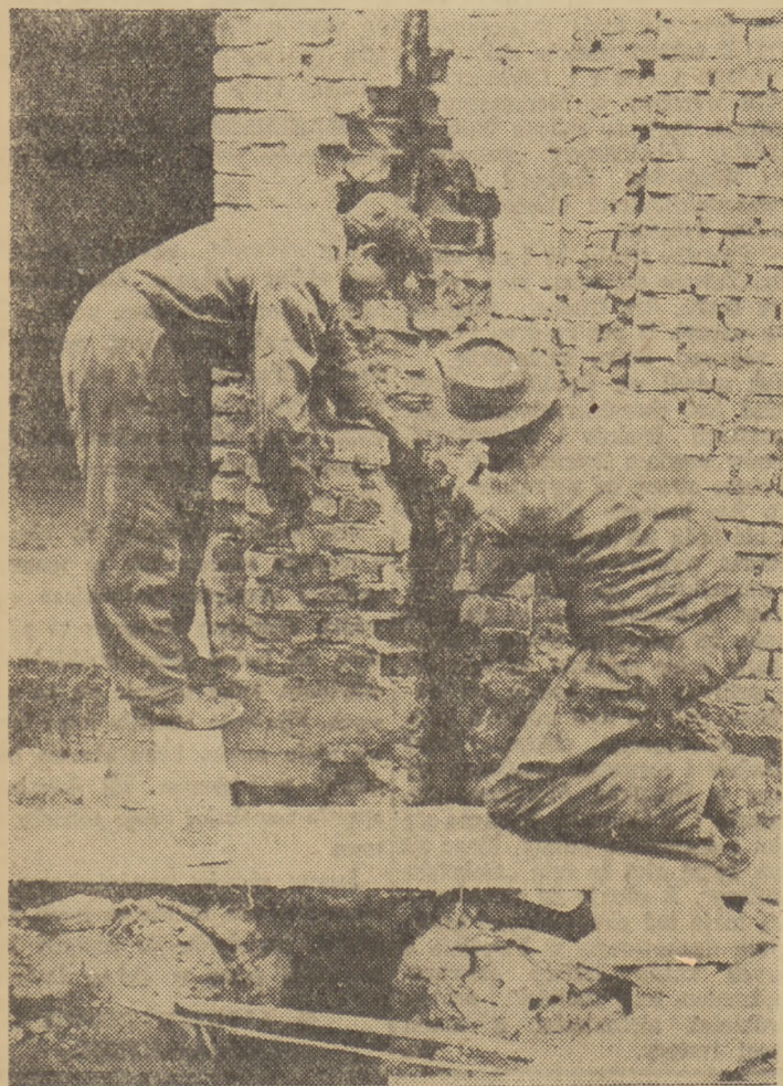
Budynki mieszkalne budowane przez ZOR w Gdańsku przy ul. Długiej zostaną już w niedługim czasie wykonane.
