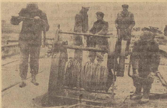
Dzięki podjęciu zobowiązań na cześć 33 rocznicy Rewolucji Październikowej, i II Światowego Kongresu Pokoju prace zostaną ukończone przed terminem. Na zdjęciu: robotnicy Pelpliński, Shibuski i Jaski z „Mostostalu” przy kolowrocie. (Foto — W. Celle).
