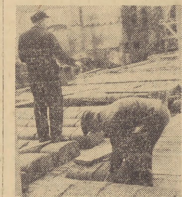
Robotnicy PPB układają pustaki prefabrykowane z gruzu-betonu na stopniu budynku mieszkalnego przy ul. Piwnej na Starym Mieście w Gdańsku.
