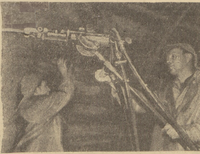
W ramach Planu 6-letniego buduje się nowe kopalnie. Przy budowie szybów używa się nowoczesnych urządzeń. Na zdjęciu: szyb budowany przez młodzi. Górnik, 29-letni Ludwik Grabowski wierci otwory w kamieniu przy pomocy świdra z podtrzymywaczem, obok zakłada obudowę żelazną 23-letni Tadeusz Stuczyński.
