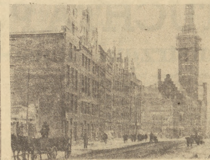
Mimo mrozu roboty budowlane na Starym Mieście trwają nieprzerwanie. Dzięki temu widoczne na zdjęciu bloki mieszkalne przy ul. Długiej Nr 57 — 66, liczące 42 mieszkania i 3 izbowa, oddane do użytku przed terminem.
