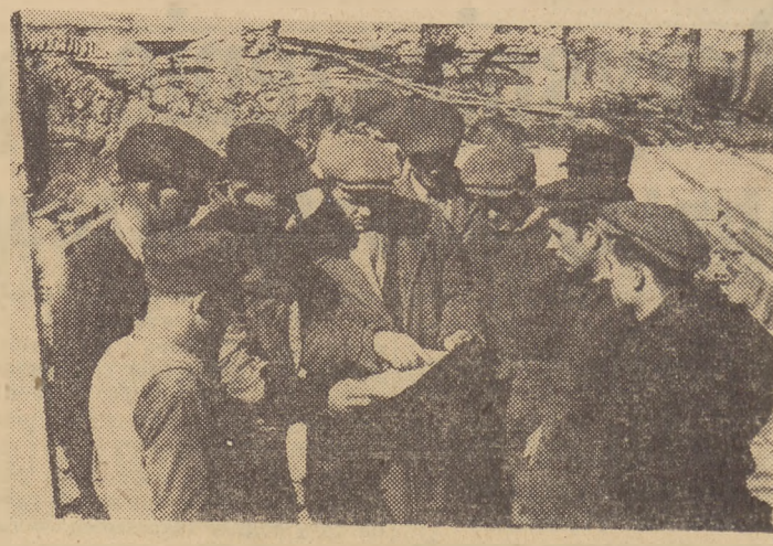
Na budowach MDM zostały wprowadzone nierozrwalne zespoły i brygady pracy.
