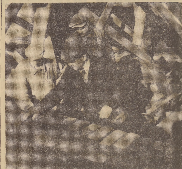
Tow. Wyszkowski, wybitny murarz gdański, który od niedawna został dyrektorem ZBM Nr 4, pokazuje robotnikom budowlany system pracy „dwójkowej”.
