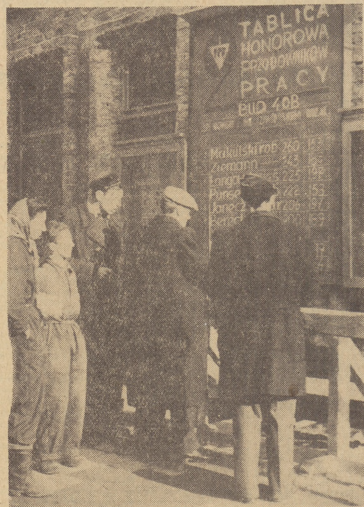
Przy ulicy Długiej w Gdańsku umieszczono szereg tablic, na których widnieją nazwiska przodowników pracy poszczególnych odcinków odbudowy miasta.
