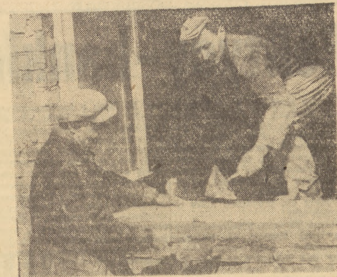
Murarze Zjednoczenia Budowlanego Mięskiego Zarządu Budowy Nr 4. B. Czeleci i J. Kowal, zatrudnieni przy budowie budynku biurowego ZPGG w Gdańsku, zobowiązali się na czasie i Maja podnieść wydajność pracy ze 172 proc. na 183 proc. Obecnie wykonują oni 220 proc. normy.
