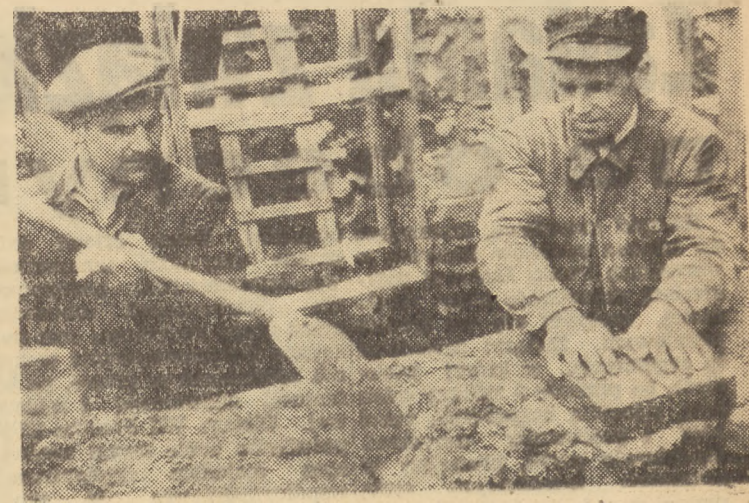
W poniedziałek dwójka murarzy Zjednoczenia Budownictwa Miejskiego (Zarząd Budowlany Nr 2), murarz Szczepan Plackowski i podrecznik Józef Kuźmicki ustanowili nowy rekord Wybrzeża w pracy murarskiej. Po przednim rekord należał do murarza Stanisława Wyszkowskiego, który w lipcu ub. roku wykonał w ciągu dnia 832 proc. normy. Oh, oh, Plackowski i Kuźmicki wykonali 875 proc. normy w ciągu 8 godzin pracy. Na zdjęciu: rekordziści przy budowie kondygnacji piwnicznych domu mieszkalnego przy ul. Piwnej w Gdańsku
