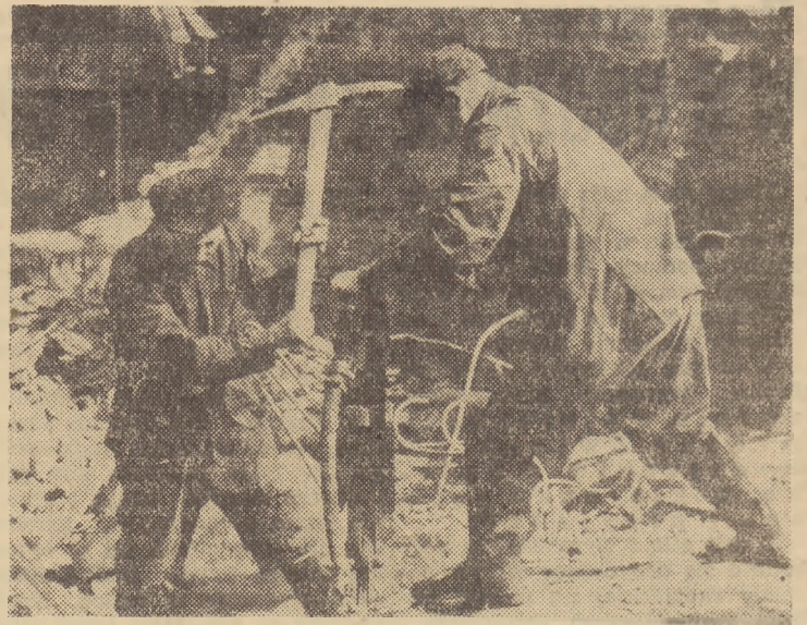
Brygada Władysława Moklewicza zobowiązała się do 1 Maja skończyć wykopy fundamentów oraz usunąć wały żelbetonowe pod przyszłą budowlą wielkiego kina w Gdańsku przy ul. Długiej. Zobowiązanie swe załoga wykonała dotychczas w 90%.
