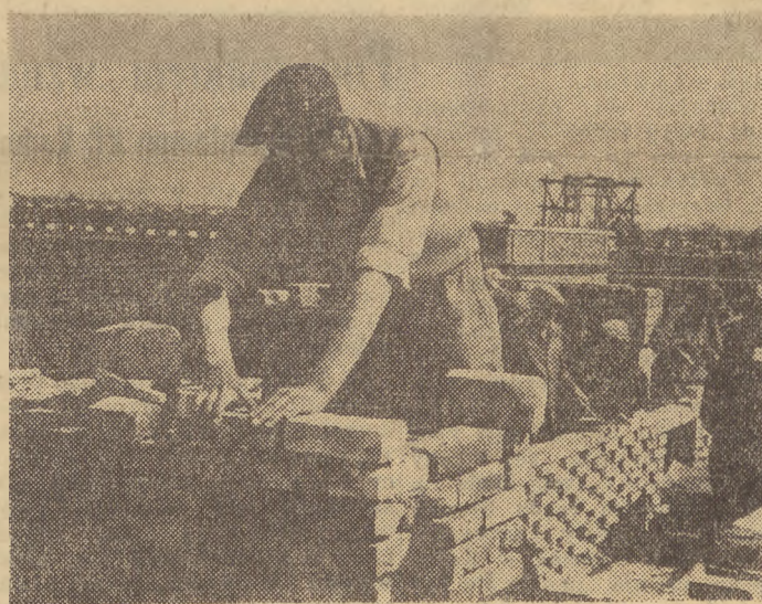
Jeden z bloków na kolonii IV w Nowej Hucie, budowany jest całkowicie przez ZMP-owców. Na zdjęciu: Murarz Henryk Garstka (ZMP) osiąga 145 proc. normy.
