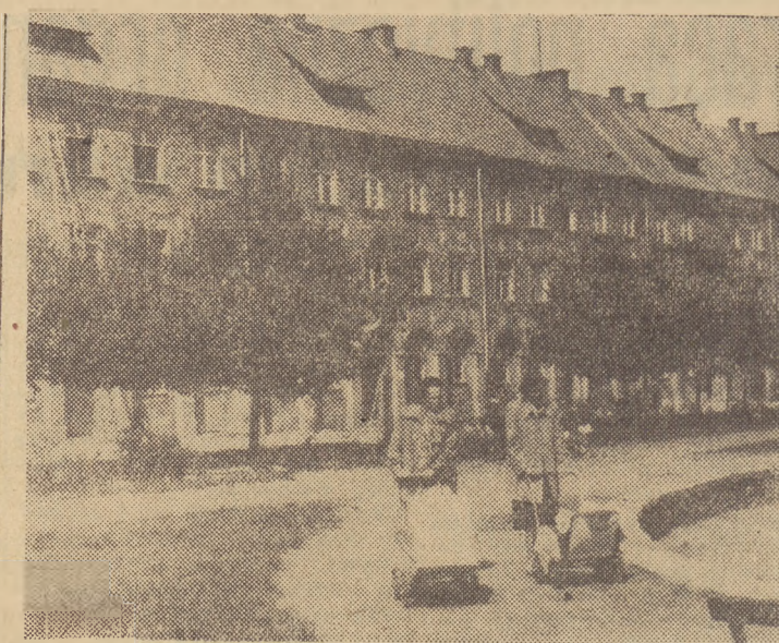
W najbliższych dniach zostanie przejęany do użytku nowy blok mieszkalny przy Placu Wybickiego we Wrszczcu. Na zdjęciu: fragment odbudowanego bloku.
