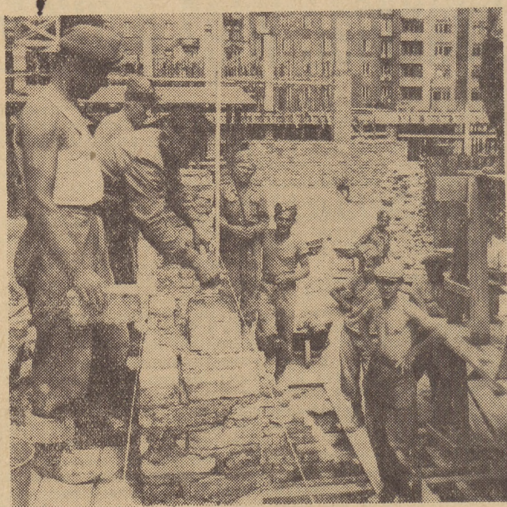
Znany przodownik murarski i racjonalizator, obecnie instruktor modernizacji produkcji — Wacław Poręcki demonstruje na budowie Marszałkowskiej Dzielnicy Mieszkaniowej rozkładanie zaprawy przy pomocy specjalnie do tego przystosowanej szufli. Próbowi tym przyglądają się junacy SP z brygady 1 B. (CAF)
