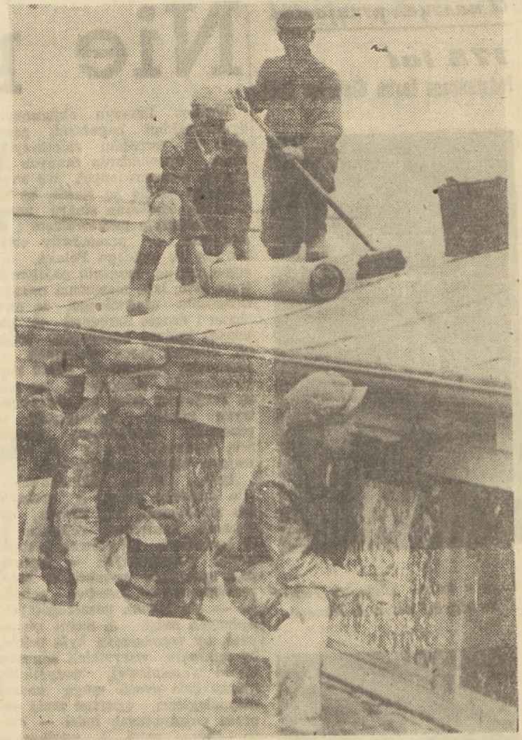
W Wrzeszczu buduje się obecnie Wytwórnię Wyrobów Mleczarskich, która wyposażona będzie w nowoczesne urządzenia techniczne. Na zdjęciu: brygada Próżniaków, wyrabiająca przeciętnie ponad 200 proc. normy. Na pierwszym planie Stanisław Wędek oraz Kazimierz Walec przy pracy.
