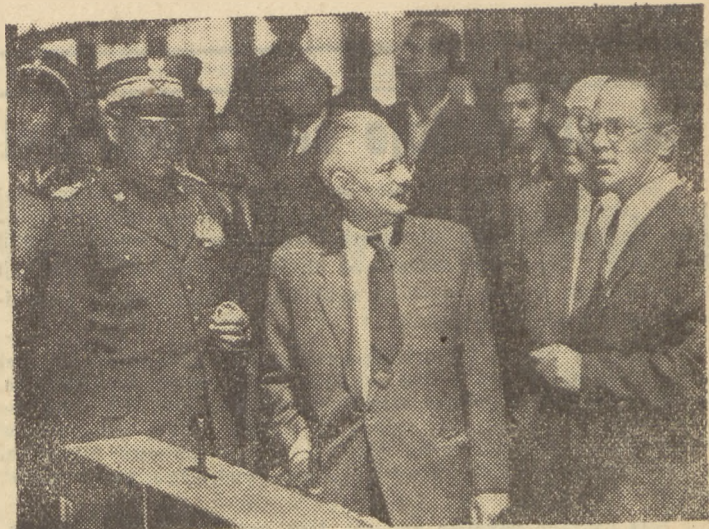
W dniu 12 czerwca 1951 r. na 40 dni przed wyznaczonym terminem ruszyła największa i najnowocześniejsza w Polsce stalownia w Częstochowie. Na uroczystość uruchomienia nowej stalowni przybyli: Premier Cyrankiewicz, wicepremier Minc i Zawadzki. Minister Obrony Narodowej Marszałek Rokossowski, ministrowie Tokarski i Babiński oraz sekretarze KC PZPR Zambrowski i Ochab.
