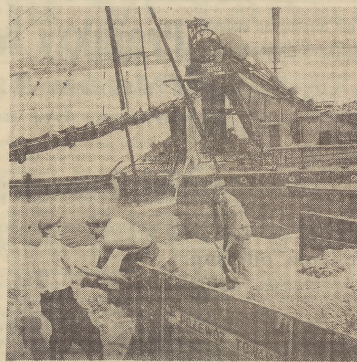
Wydobyt z dna Wistły piasek służy do odbudowy stolicy. Na zdjęciu: piasek przy pomocy transportera zostaje wydławany z pogłębiarki na brzeg. (Na pierwszym planie robotnicy załadunku piasek na samochody).
