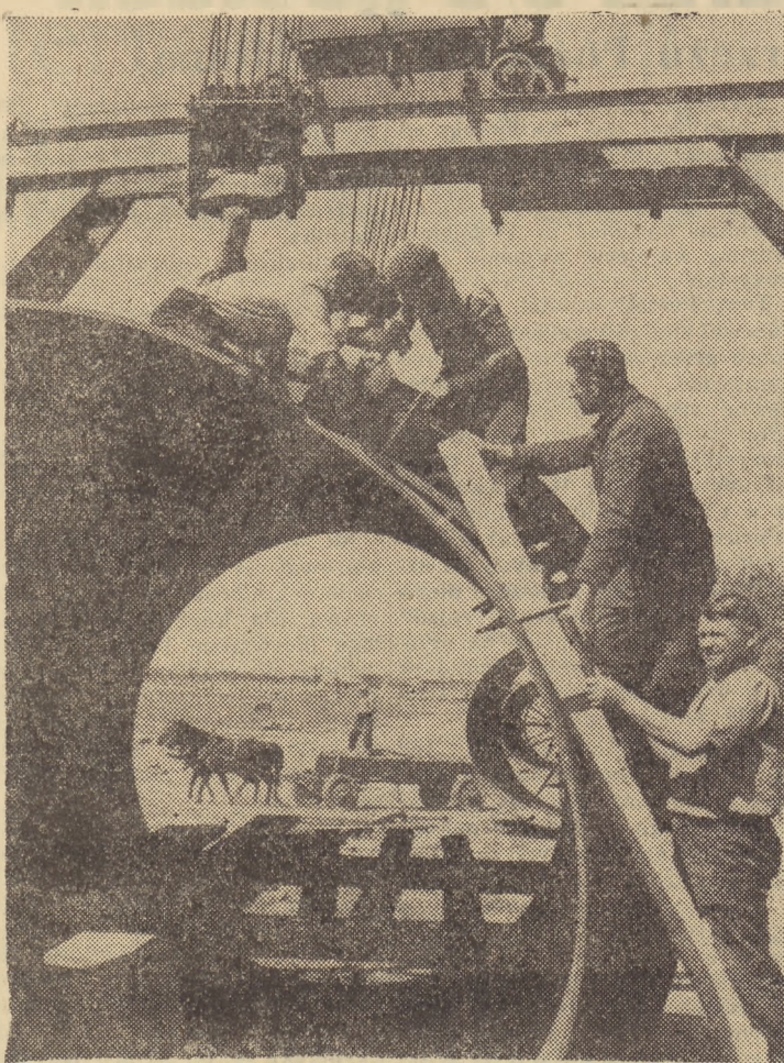
W Wierzbicy, koło Radomia, powstaje nowoczesna cementownia. Na zdjęciu: brygada Stanisława Maselki przy montażu pierścienia obrotowego pieca.
