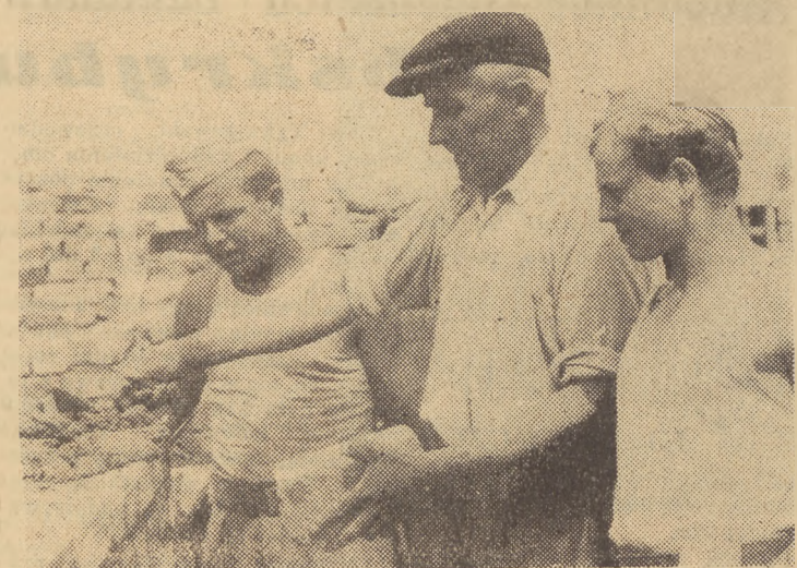
Przy budowie domów akademickich pracują junacy 18 brygady „SP”, którzy uczą się zawodu murarza. Na zdjęciu: brygadziści murarz — Leon Leszka uczą murarki junaków Bronisława Ceremugę z Żarnówki i Teofila Fryca z Ryczowa, pow. Wadowice, woj. krakowskie. Obaj junacy są przodownikami pracy i wyrabiają przeciętnie 230 proc. normy.
