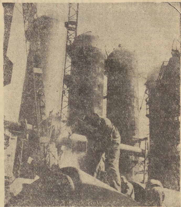
W ramach wielkich budów socjalizmu postępuje również szybko naprzód rozbudowa huty „Kosciuszko” w Chorzowie, w której powstaje wielki nowoczesny piec „B”, koksownia, siłownia i fabryka produktów ubocznych. Na zdjęciu: przelotnik pracy spawacza Jerzy Wieceorek spawa pancerze odpływnika. W głębi fragment wielkiego pieca „B”.
