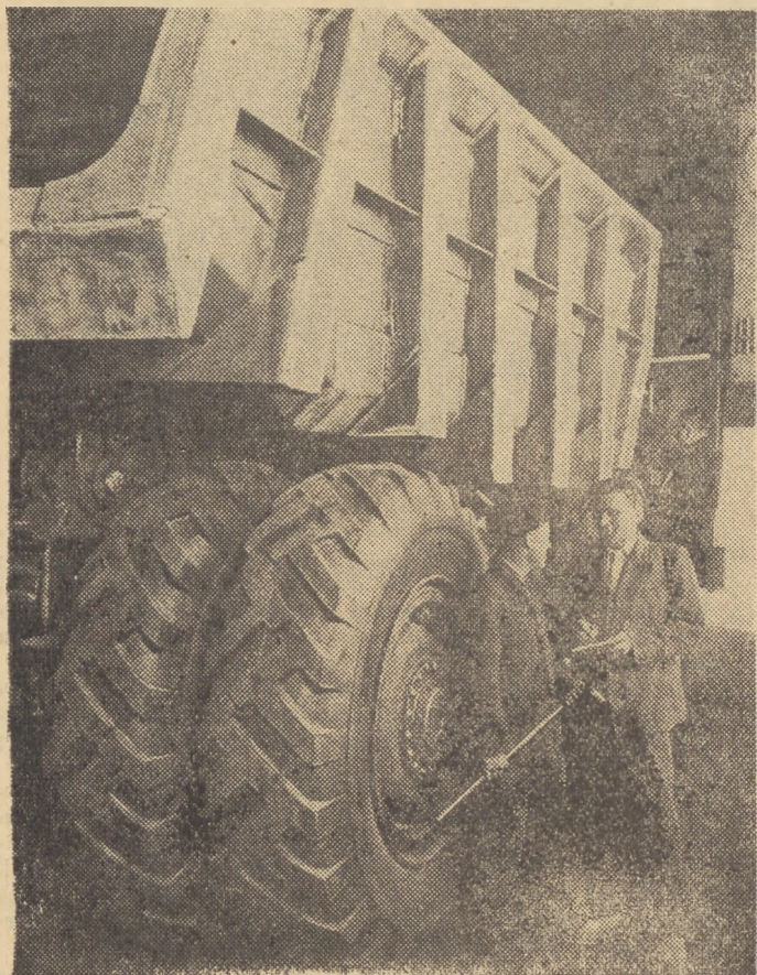
Na zdjęciu: seryjny montaż 25-tonowych ciężarówek - wywrotek w mińskiej fabryce samochodów przeznaczonych dla wielkich budowli komunizmu
