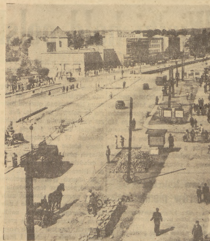
Przebudowa ulicy Grunwaldzkiej w Gdańsku.
