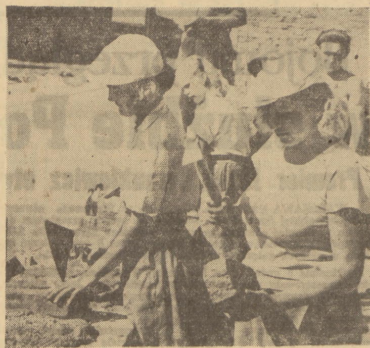
We Wrzeszczu, na budowie Grunwaldzkiej Dzielnicy Mieszkaniowej, pracują kobiety murarze. Na zdjęciu: Krystyna Rozczyk i Bronisława Małek z Zarządu Budownictwa Miejskiego nr 2 w Gdańsku przy pracy.
