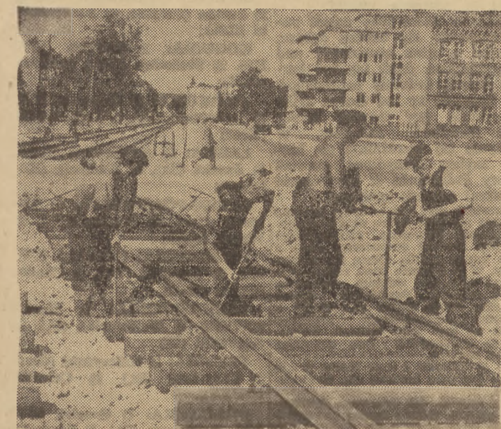
Nowa linia tramwajowa na ul. Grunwaldzkiej wydłuża się z dnia na dzień. Pracujący przy jej budowie robotnicy WPKKG J. Derkowski, T. Prociński i Z. Iwanik wykonują przeciętnie po 180 normy.
