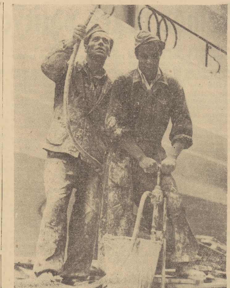
Coraz więcej robotników budowlanych systematycznie przekracza normy. Na zdjęciu: malarze Z. B. Nr 3 w Gdańsku Piotr Iljin i Alojzy Barczyński, zatrudnieni przy robotach malarskich w gmachu PZZ przy ul. Długiej, osiągając od dłuższego czasu około 220 proc. normy.
