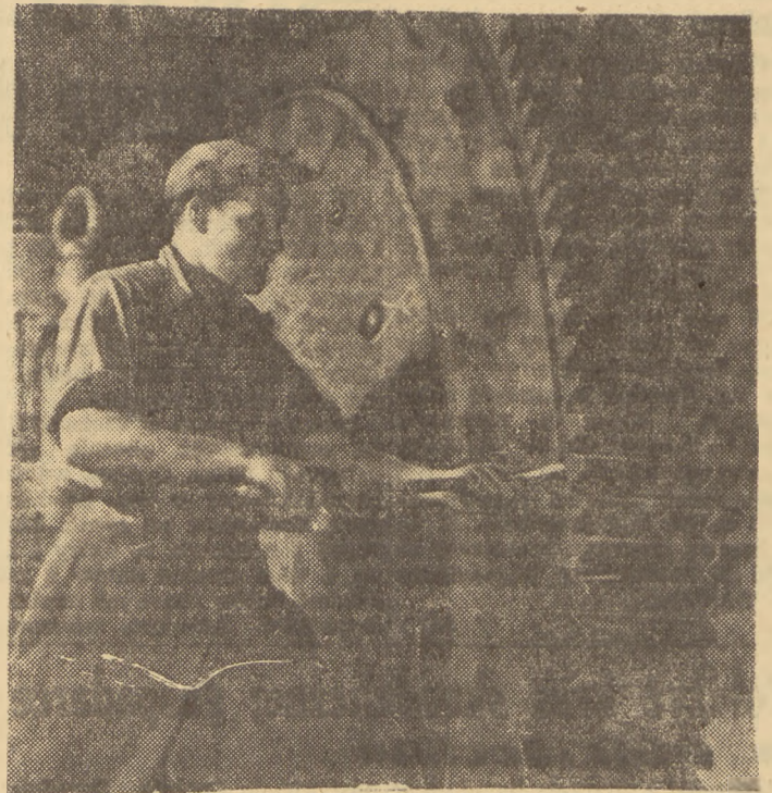
W Miechowie, na Dolnym Śląsku, prowadzone są intensywne prace przy budowie olbrzymiej elektrowni węglowej. Elektrownia ta będzie największą jednostką tego typu w Polsce. Elektrownia rozpocznie produkcję już w początkach roku 1952.
