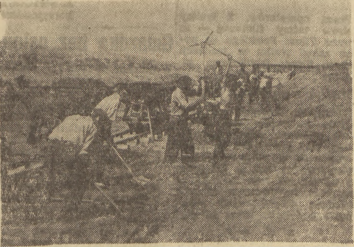
Na zdjęciu: budowa linii kolejowej Kielce — Busko. CAF—fot. Banduch
