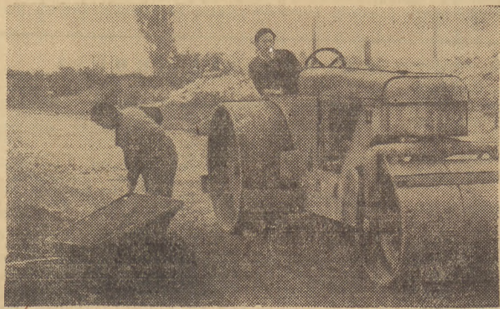
Mechanik Wojewódzkiego Przedsiębiorstwa Robót Drogowych — Emil Kryper kilkunastym walcem wyrównuje teren 6-cio torowej bieżni.
