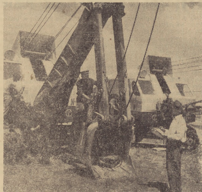
Na budowę kochowskiego hydrowęzła przybyły nowe maszyny.
