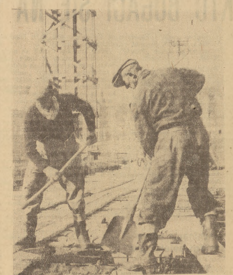
Budowniczowie Grunwaldzkiej Dzielnicy Mieszkaniowej dla uczczenia 34 rocznicy Wielkiej Październikowej powieli szereg zobowiązań zespołowych i indywidualnych, których wartość wynosi 26.778 zł. Brygada betoniarzy Karola Szlaga zobowiązała się złożyć beton na stropach budynku 35-41 oraz za betonować strop nad piwnicą i parterem budującego się zlozka. Na zdjęciu: Karol Szlaga i Franciszek Kitowski przy betonowaniu stropów pierwszego piętra budynku 35.
