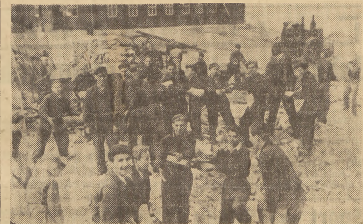
Pracownicy WPKGG odgryzowali w ramach zobowiązań październikowych zniszczoną podstację.
