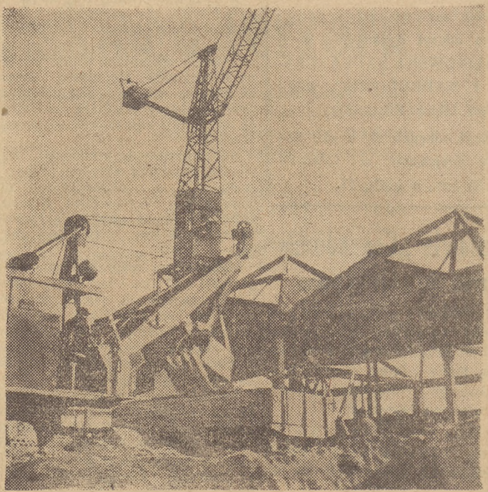
Budowa Fabryki Armatur w Borku Fałęckim pod Krakowem postępuje szybko naprzód. Hale nowej fabryki wykonane są wyłącznie z prefabrykatów żelbetonowych.
