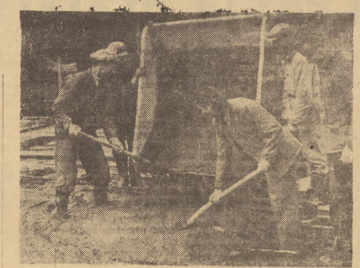
Studenci Wyższej Szkoły Pedagogicznej w Gdańsku zobowiązali się uczcić 34 rocznicę Rewolucji Październikowej tygodniową pracą przy budowie nowego domu akademickiego przy ul. Morskiej we Wrzeszczu. Na zdjęciu: grupa studentów pracuje przy betonowaniu.
