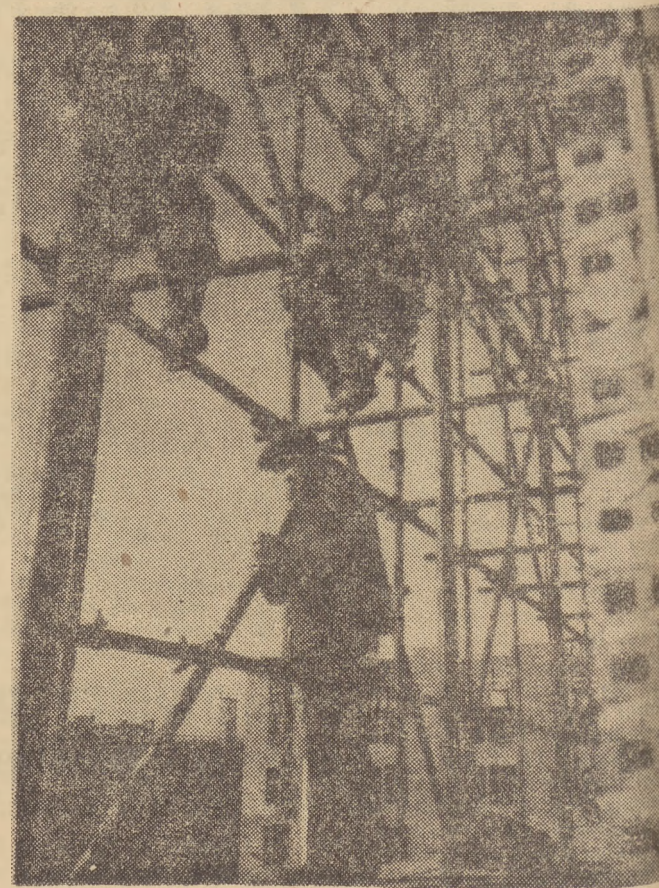
Zakładanie rusztowań na blokach Marszałkowskiej Dzielnicy Mieszkaniowej. Na zdjęciu: Grupa monterów Kazimierza Dziwiałkiewicza wykonująca 250 proc. normy, przy zakładaniu rusztowań typu ciężkiego.
